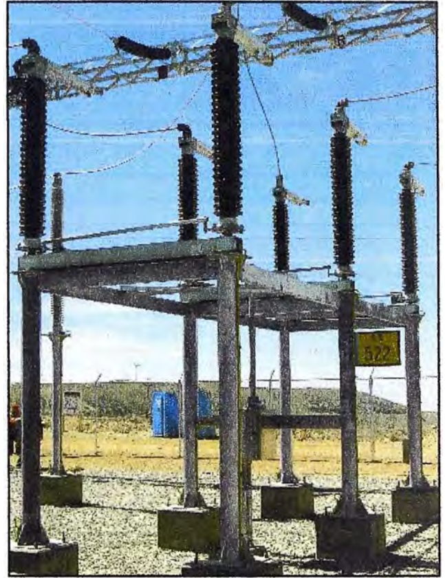
Seccionador de potencia "DS - 522"
