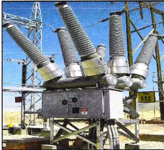
Figura 1.7: Interruptores en SF6 (hexafluoruro de azufre)
