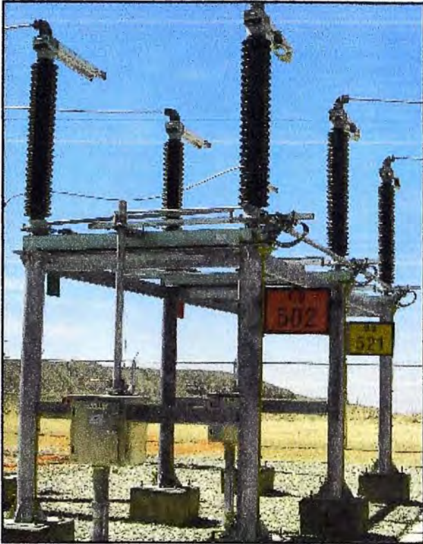
Seccionadores de Potencia "DS - 521 y GS - 502"
