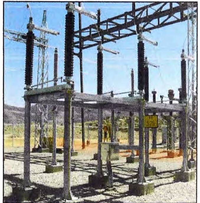
Seccionador de Potencia "DS - 525"
