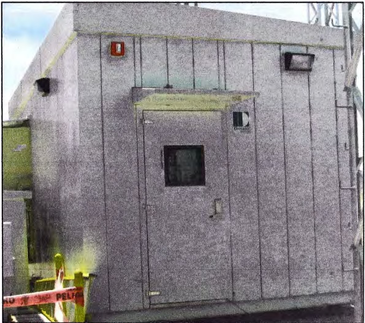
Figura 1.1: Sala de control
