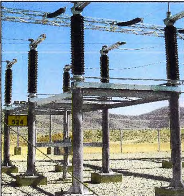
Seccionador de Potencia "DS - 524"
